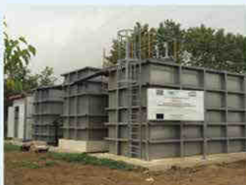
Compact μονάδα επεξεργασίας αστικών λυμάτων τεχνολογίας MBR της Κοιν. Στενημάχου Νάουσας Οργανική φόρτιση 60 kgBOD 5 /d (1.000 ισοδύναμα άτομα)
