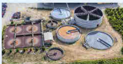
Μονάδα επεξεργασίας αποβλήτων χυμοποιίας ΑΙΓΠΙΕ Οργ. φόρτ. 10.000 kgBOD 5 /d (153.800 ισοδύναμα άτομα)
